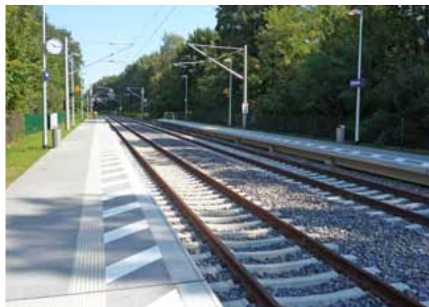
Station Zeesen – Streckeninfrastruktur nach Abschluss der Bauarbeiten.
