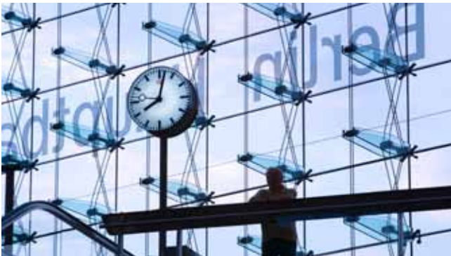
Berliner Hauptbahnhof – Glasfassade mit Bahnhofsuhr.
