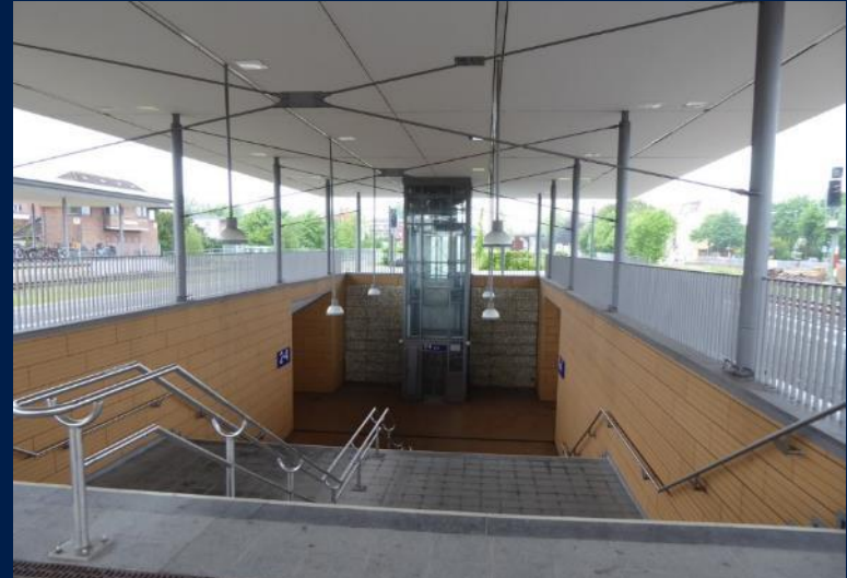
Neues Bahnsteigdach in Heide
