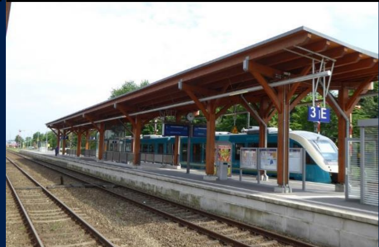
Rekonstruiertes Dach in Niebüll
